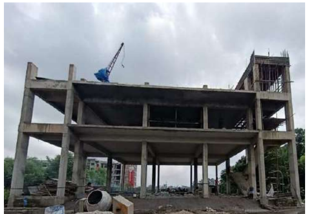
Staff Accn Bldg
